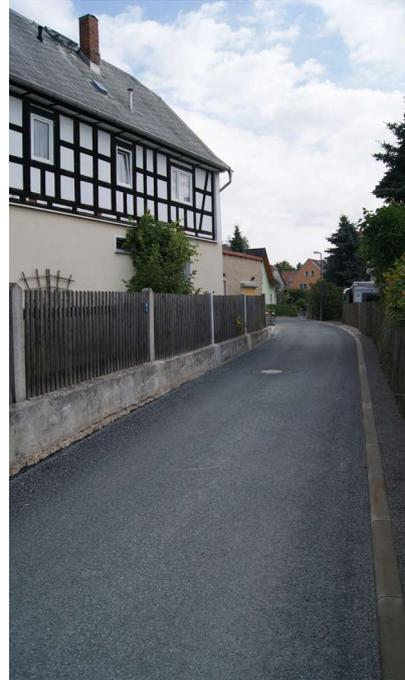
Nach einer Neuprofilierung der Oberfläche, der Herstellung einer wasserführenden Betonborde, der Auskoffierung des Straßenkörpers sowie dem Einbau einer Sauberschicht wurde als Fahrbahnbelag eine zehn Zentimeter starke Asphalttragdeckschicht eingebaut.
