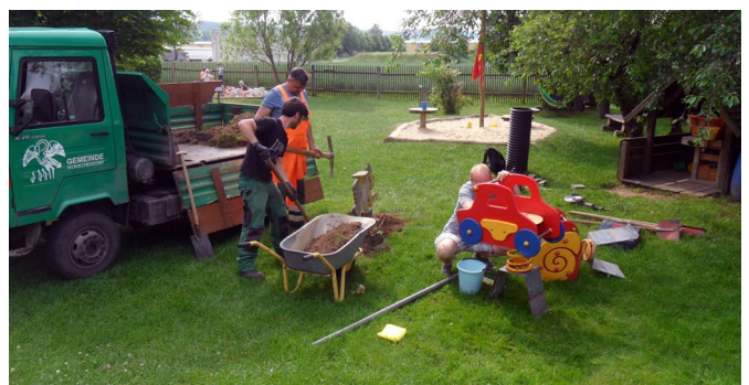
Unsere fleißigen Bauhofarbeiter bauen neue Geräte auf
