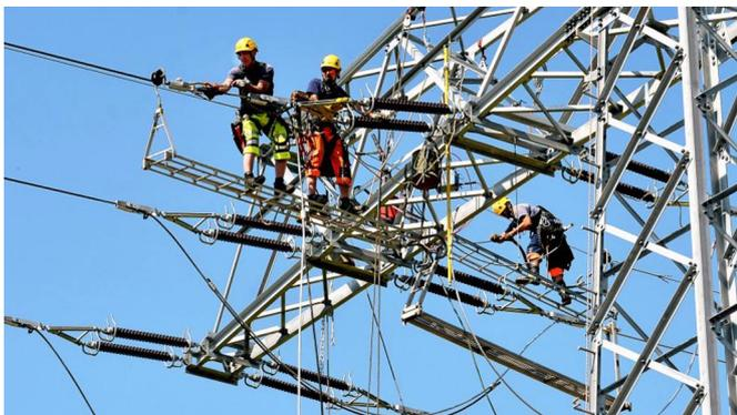
Wegen neuer gesetzlicher Bestimmungen hinsichtlich Höhe und Tragfähigkeit speziell an Straßenüberquerungen, Wasserläufen und Querungen von Eisenbahnstrecken, wurden die bestehenden Masten an diesen Kreuzungspunkten durch größere und stabilere Masten ersetzt.
