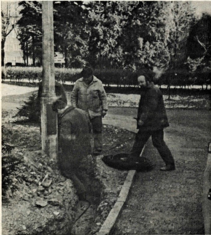
Zur Verbesserung der Straßenbeleuchtung in der Stadt wurde eine weitere neue Straßenlampe vor dem Fitkost-Geschäft in der Bahnhofstraße errichtet, die seit 14 Tagen ihren Dienst tut. Leider ist es derzeit nicht möglich den Weg freizuräumen, da der Frost ein Beiseiten des Erdaushubes nicht gestattet.
