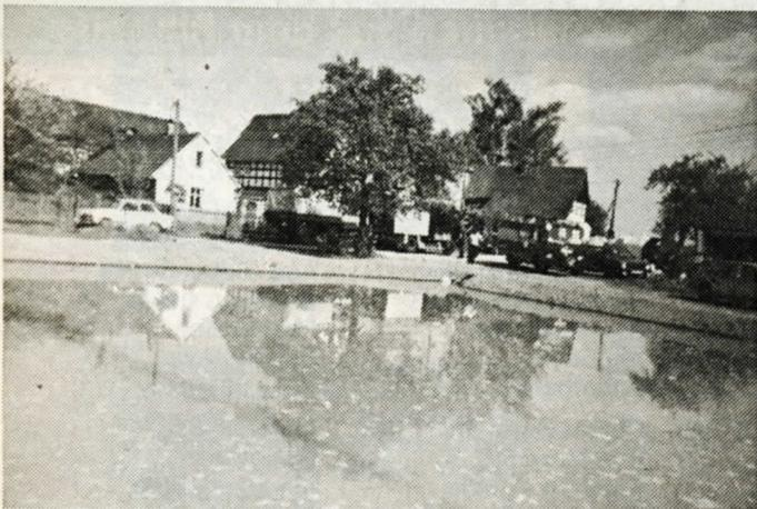
Nach Fertigstellung der Sanierung des Dorfteiches Großdraxdorf durch die Fa. G. Reinhold, Mohlsdorf, konnte der langjährige »Trockenteich« wieder als Löschwasserreserve gefüllt werden. In die Grundfläche des Teiches wurde Folie eingebaut; dazu konnte eine 60%ige Förderung aus dem Dorferneuerungsprogramm erreicht werden.
