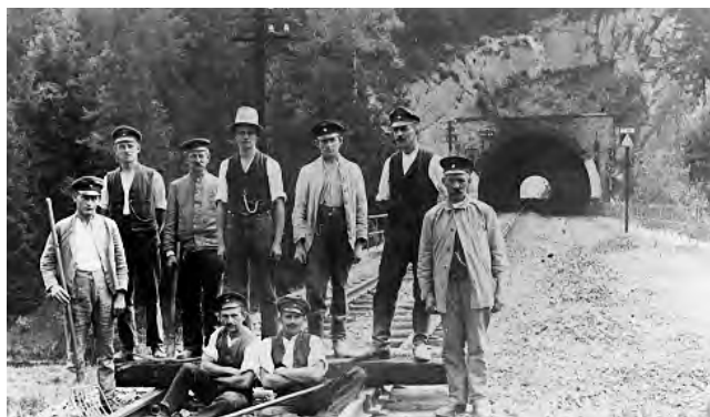
Gleisarbeiter beim Eisenbahnbau – Jahr 1876? vor dem Rüßdorfer Tunnel? Die Breite des Tunnels war schon damals vorgesehen für eine zweispurige Ausführung der Strecke
