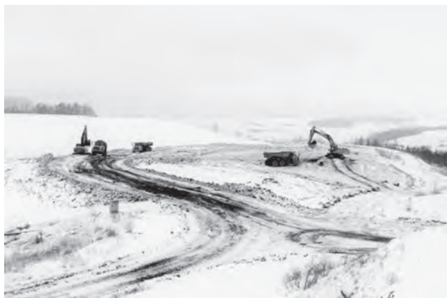
Abtragsarbeiten auf der Waldhalde
