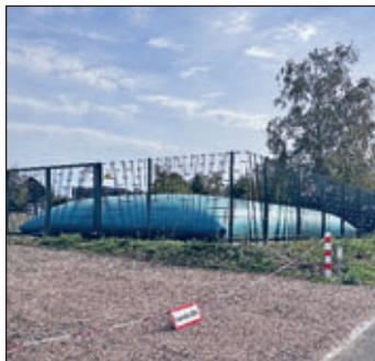
Löschwasserbehälter Eula
