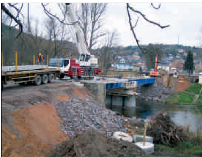
21.11.2006 • Montage der Behelfsbrücke Ortseingang Berga
