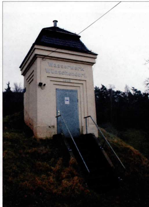
Auch der Trinkwasserhochbehälter Hütchenberg steht für die Versorgung für Wünschendorf zur Verfügung. Quelle: OTWA
