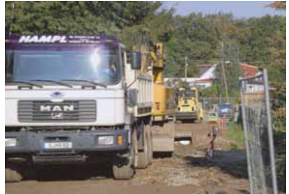
An drei Abschnitten gleichzeitig wird in Meilitz gebaut
